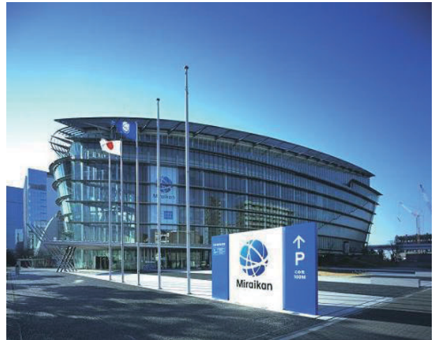
図-1 建物外観 (写真は日本科学未来館提供)
